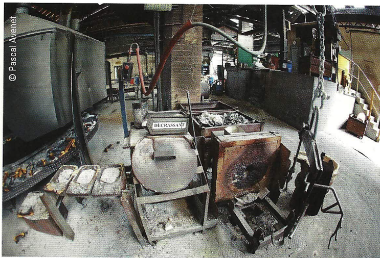
Voilà ce qu'il reste de la fonderie de Bléré... Depuis qu'elle a fermé ses portes en 2009, elle n'est plus qu'une usine désaffectée.
